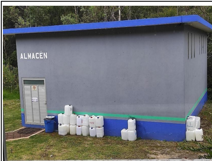
Imagen 39. Almacén de materiales, atrás del edificio C.
