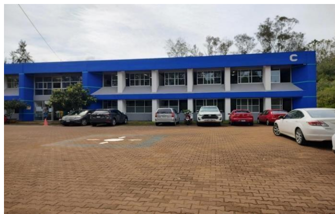
Imagen 32: Estacionamiento del edificio C
