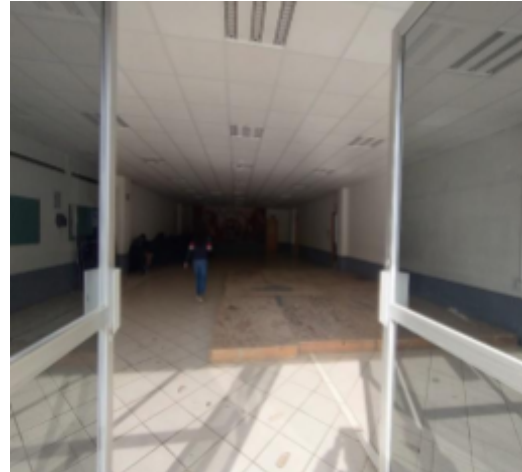
imagen 26.- Laboratorio de tic's, edificio B
