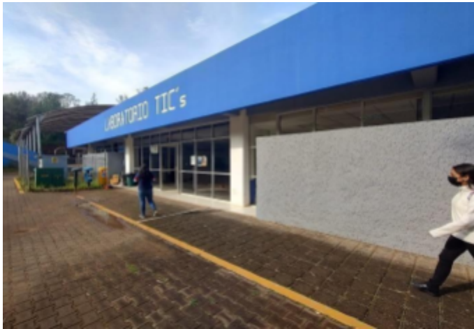
Imagen 27.- Entrada al edificio B, pasillo con acceso a los salones
