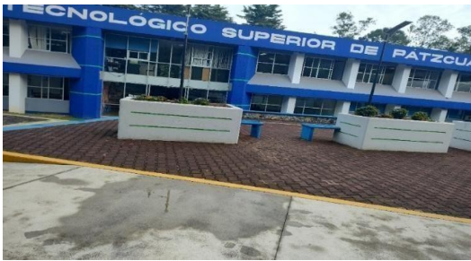
Imagen 16. Patio fuera del edificio A.
