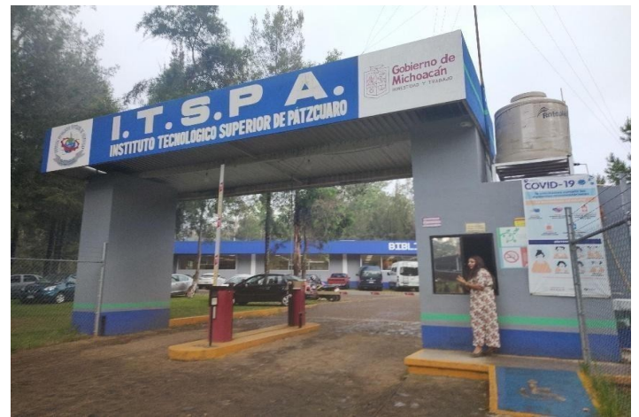
Imagen 44.- Caseta de la entrada del estacionamiento
