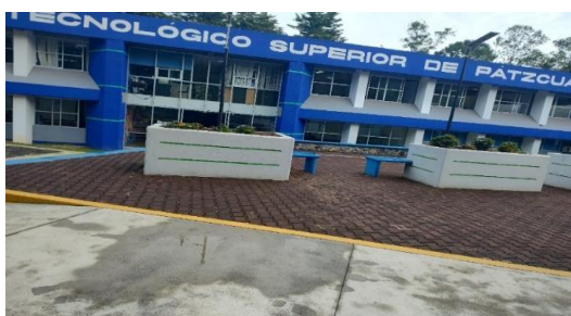
Imagen 16. Patio fuera del edificio A.
