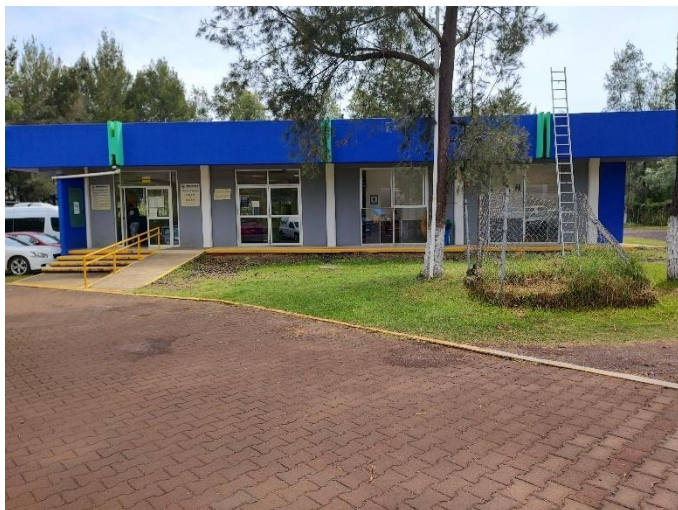
Imagen 35. Vista frontal de la biblioteca.
